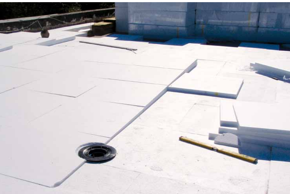
Jól látható a lejtésképző hőszigetelés kialakítása
