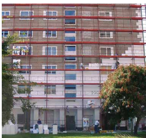
Panelszigetelés 16 cm vastag Austrotherm lemezekkel
