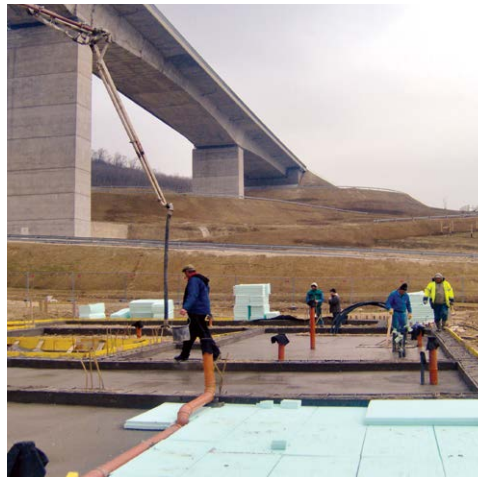
Lemezalap alatti hőszigetelés Expert és Xps anyagokkal.
