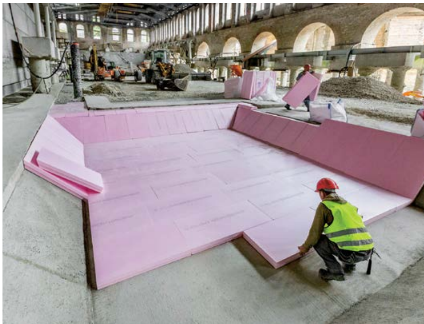
Biztos alapokon: a múzeum alsorsori szintjén nagy teherbírású Austrotherm XPS® TOP 70 hőszigetelő lemezeket helyeztek el.
