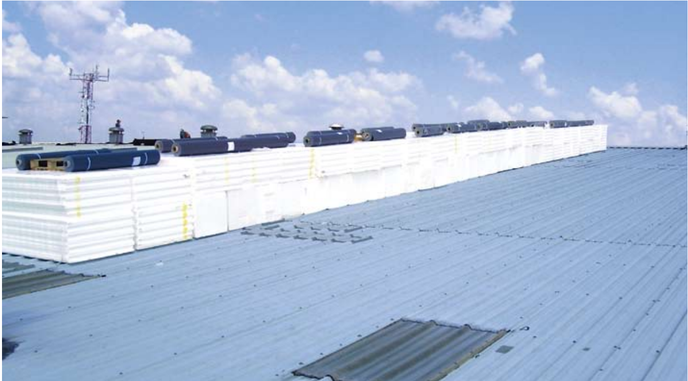
Könnyszerkezetes tető hőszigetelése Austrotherm lemezekkel
