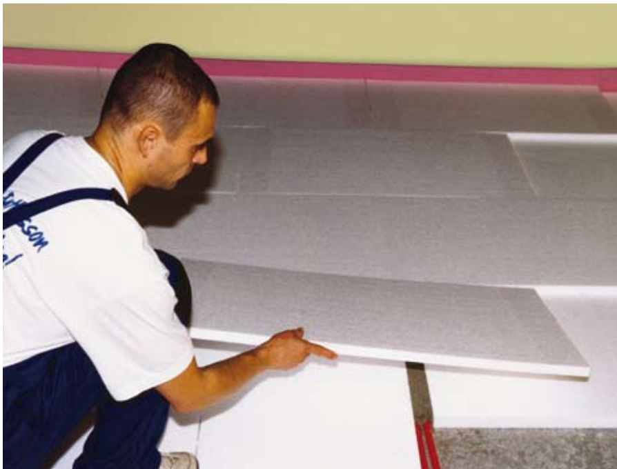
Ha a födémén csövek futnak, két rétegben kell fektetni
