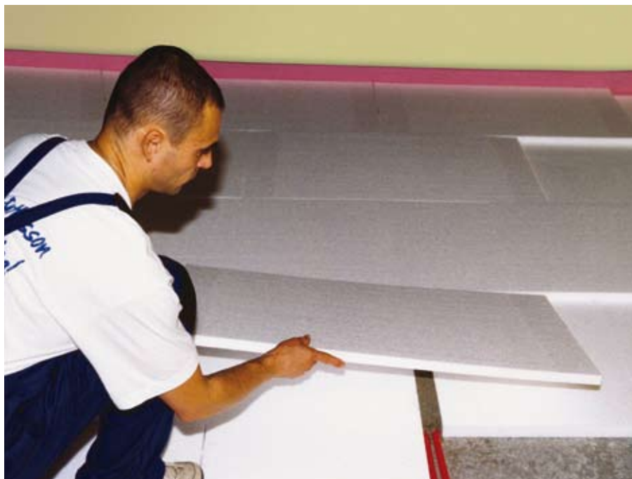
Ha a födémén csövek futnak, két rétegben kell fektetni
