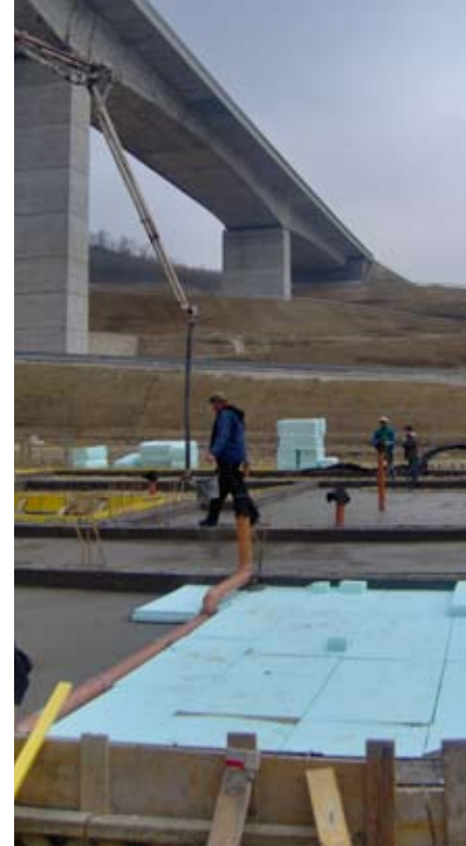
Alapozás a Köröshegyi Völgyhíd hídmérnökségi épületénél
