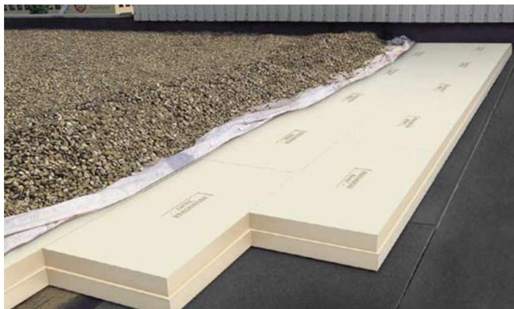
A hőszigetelést kavics-terheléssel rögzítik
