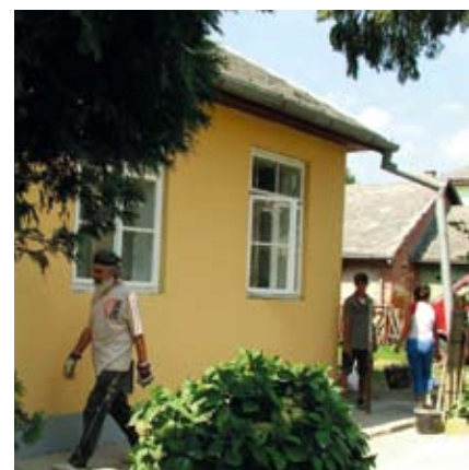
A felújított épület (Fehér Katalin fotója)
