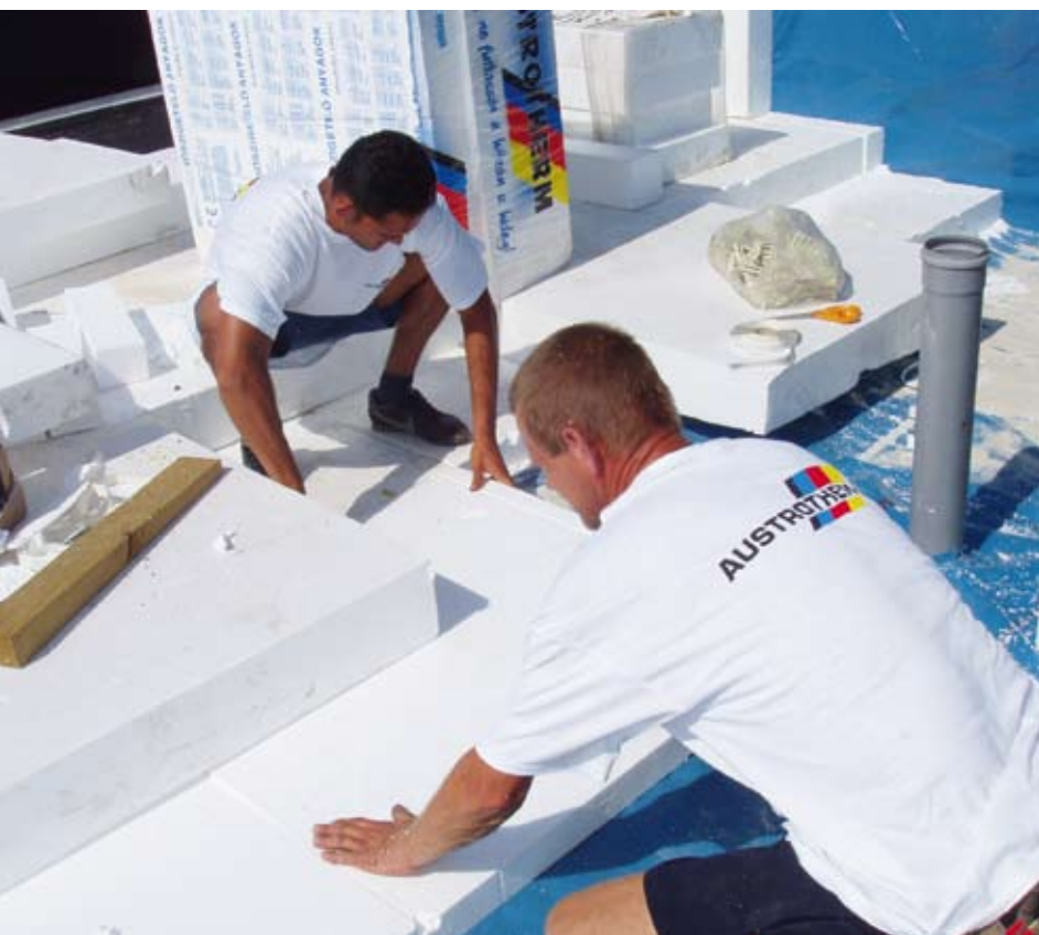
Lapostető hőszigetelése
