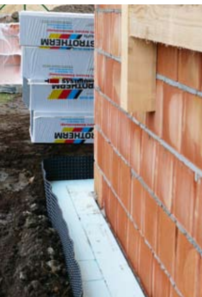
A talajba kerülő szerkezetek hővédelméről az Expert lemez gondoskodik
