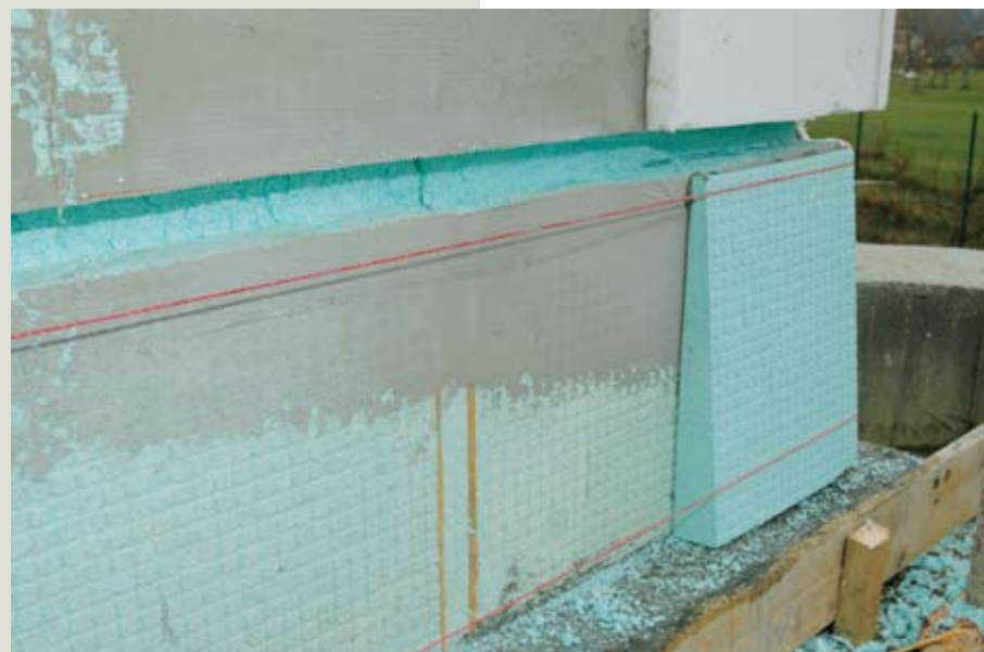
Lábazat kialakítása lejtésbe vágott Austrotherm Expert Fix lemezekkel
