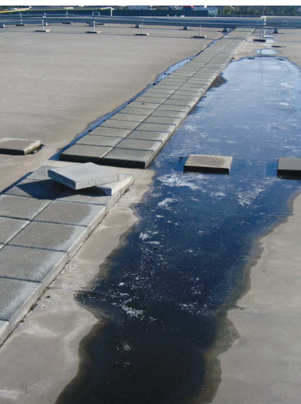
A lejtés nélkül vápában visszamaradó, megfagyott csapadék
