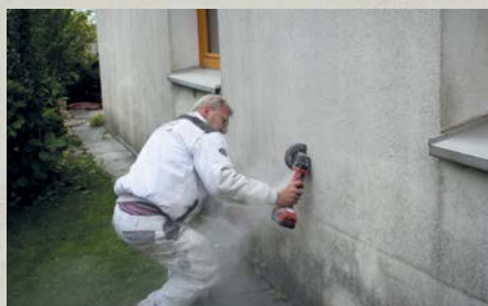
A homlokzat lecsupasztásakor a vakolatot általában függőlegesen vágják be...
