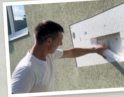
Ebben az esetben újra kell hőszigetelni az épületet.
