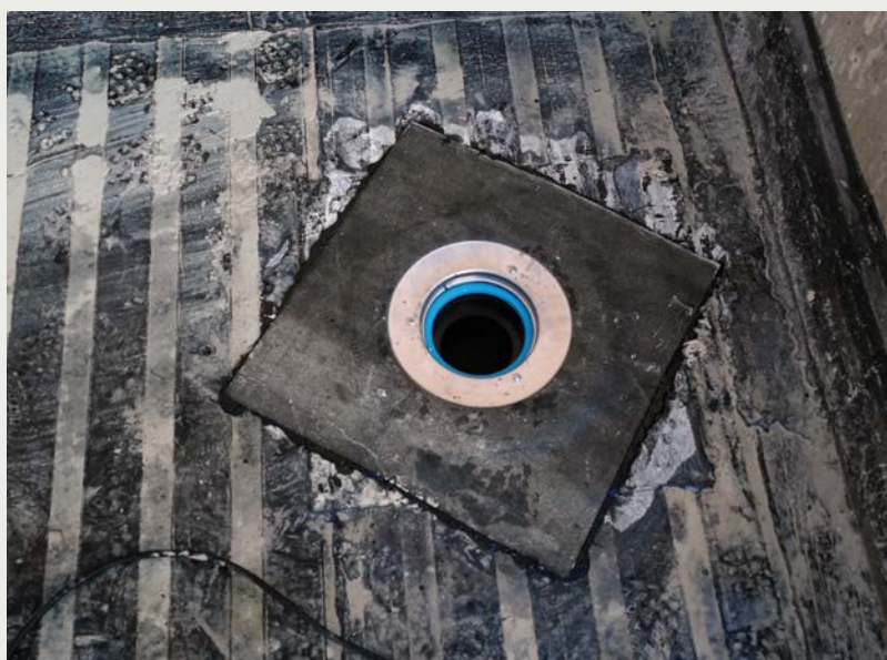
2. fotó: A párazáró réteget a kéttölcséres víznyelő alsó részéhez vízhatlanul csatlakoztattuk.
