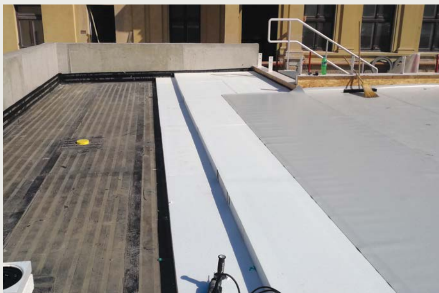
3. fotó: A víznyelő felső részéhez a PVC csapadékvíz elleni szigeteléssel csatlakoztunk.
