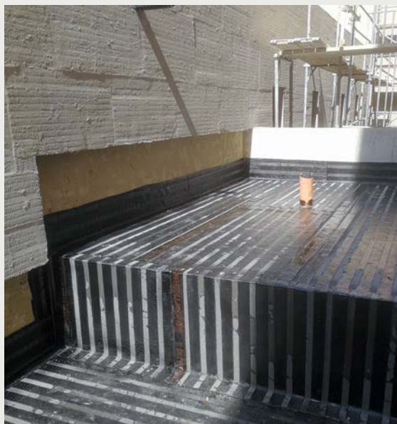
1. fotó: A párazáró réteg felvezetése a hőszigetelés felső síkjáig
