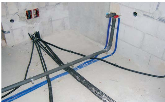
A lépéshang-szigetelésnél problémát okozhatnak a födémén futó csövek....
