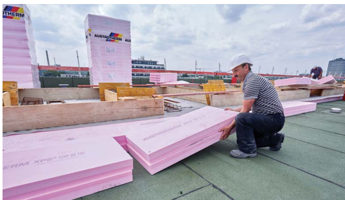
A maximális, 400 mm vastagságú Austrotherm XPS® TOP 30 TB szigetelést építették be. Fotó: Austrotherm
