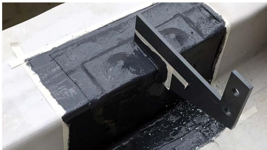
5. fotó: A korlátartó konzolt poliuretán alapú, egykomponensű bevonatszigeteléssel vízhatlanul csatlakoztattuk az attika PVC vízszigeteléséhez.
