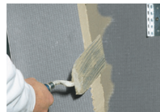
Die Austrotherm UNIPLATTE® kann sofort aufgebracht werden. So ist der rechte Winkel gesichert.
