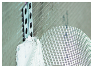
Mit Glasseiden-Gewebestreifen schließen sich Plattenstöße.
