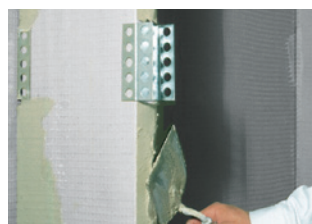
Auch die Murexin Verbindungs-klammer ist rasch montiert.
