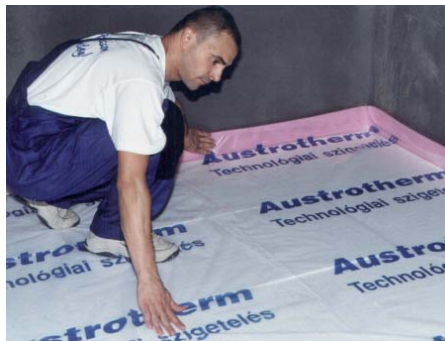
A technológiai fólia elhelyezése
