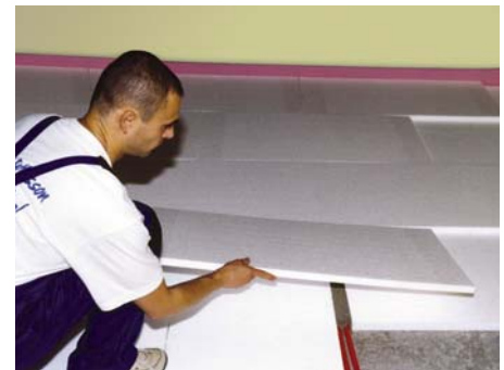
Ha a födémén csövek futnak, két réteget kell fektetni
