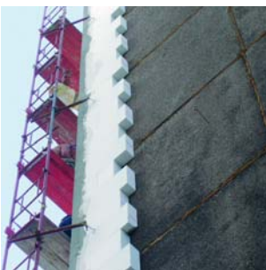
Homlokzatszigetelés Austrotherm AT-H80-as lemezzel
